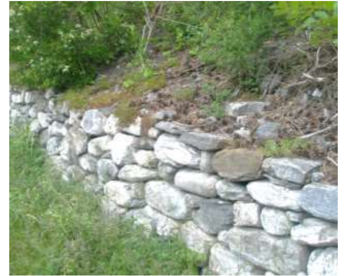
Trockenmauern erstellen
